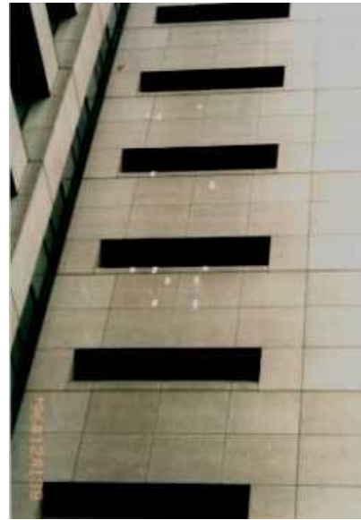
外壁の吸着作業
