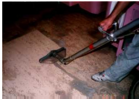
しみ込みの多い石は水を吹きつけ吸引
