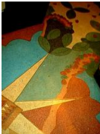
現場研ぎ出しテラゾー
