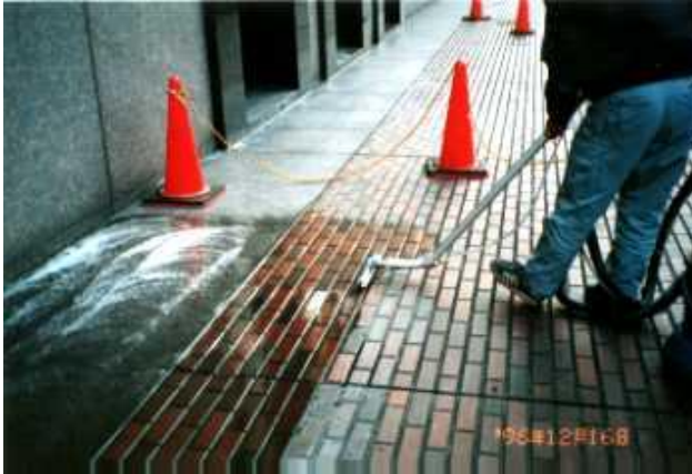
染み抜き後のすすぎ作業
