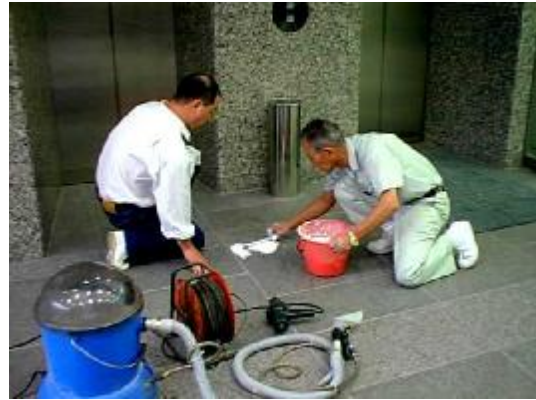
バーナー仕上げは汚れがしみ込み易い この例はマヨネーズなどの汚れであるが、 すぐに浸透性の少ないカーペット洗剤で 洗浄処理してあったので、吸着法で簡単 に処理できた。
