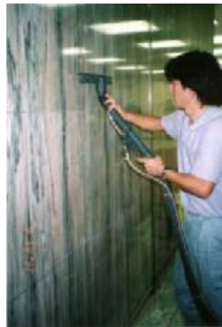
壁面のリンス作業
