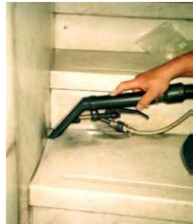
前染み抜き洗浄後のすすぎは、かなりのしみが取れる。 内部汚れを水と共に吸い上げる。吸引力が鍵になる。
