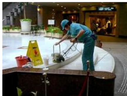
酸化アルミによる艶戻し
