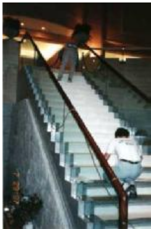
階段部分の湿布法
