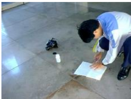
ライムストーン（ジェラストーン）の錆取り後のライムストーンの艶戻し
