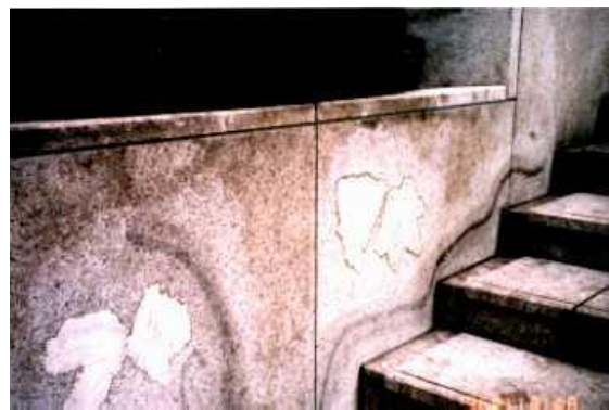
マジックインクの吸着染み抜き
